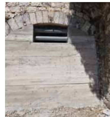
Fermeture d'un bunker.
